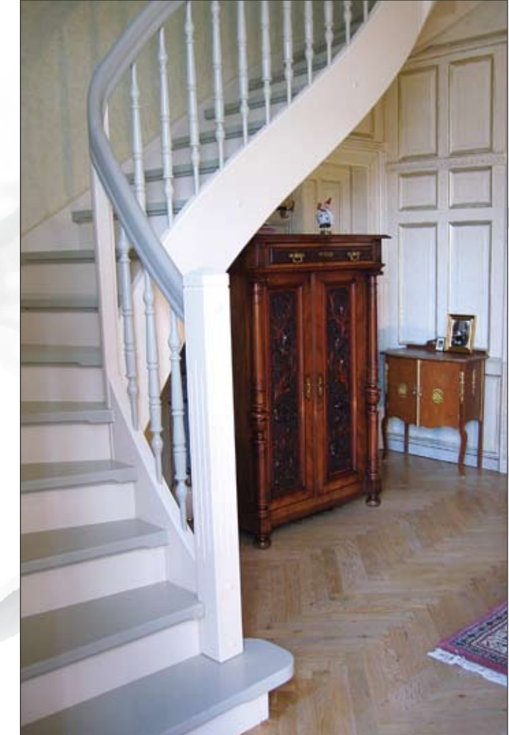
9 Massivholzwangentreppe 2 x ¼-gewandelt in Buche lackiert mit gedrehten Geländerstäben, Krümlingspfosten und Setzstufen.
