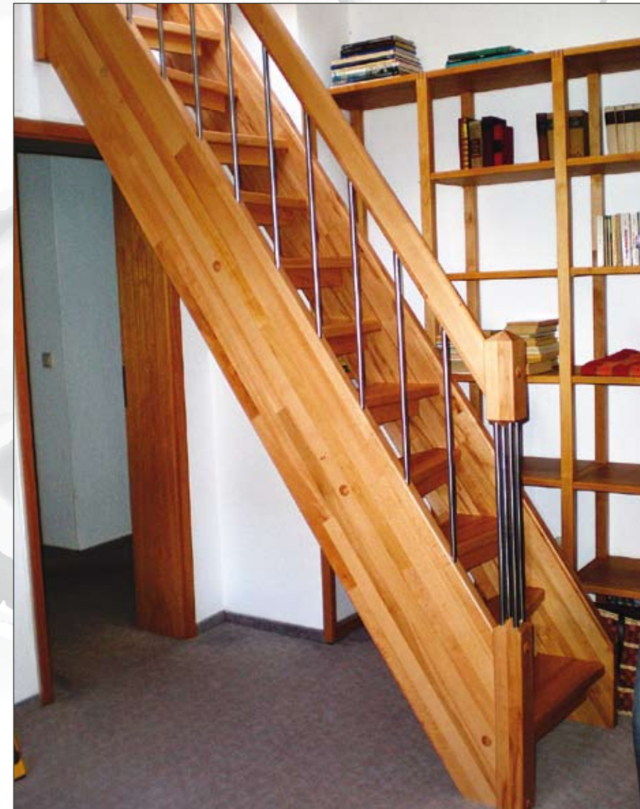
16 Massivholzraumspartreppe in Buche mit Edelstahlstäben
