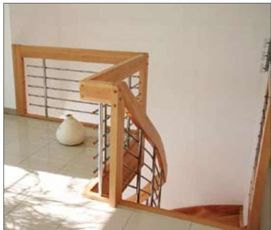
14 Massivholzbolzentreppe ¼-gewandelt in Buche mit horizontale Edelstahlstäben.
