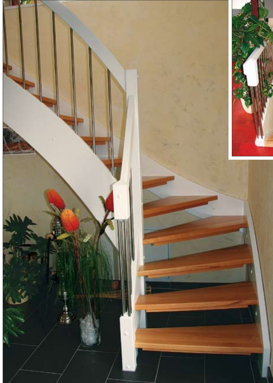
10 Massivholzwangentreppe ¼ gewandelt in Buche. Wangen weiß und Stufen farblos lackiert. Kinderschutzleisten unter den Stufen.
