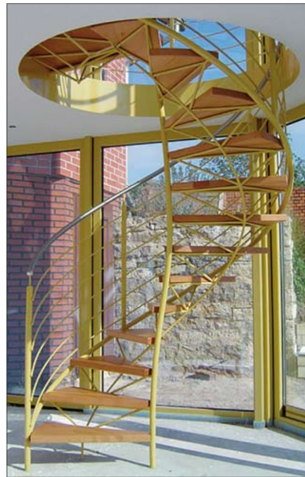
35 Tragwerkspindeltreppe mit Buchenstufen.
