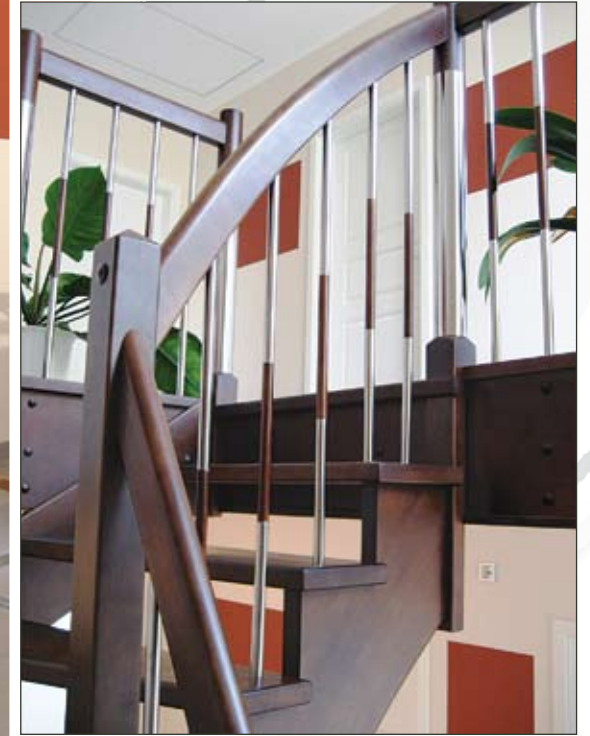
11 Massivholzwangentreppe 2 x ¼-gewandelt in Buche gebeizt mit Edelstahlgeländerstäben und -pfosten.
