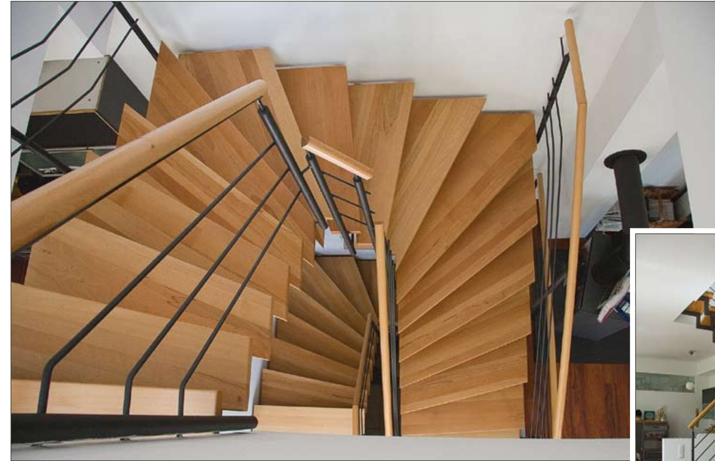
25 Zweiholmtreppe 2 x ¼-gewandelt mit horizontalen Stäben. Handlauf und Stufen in Buche.
