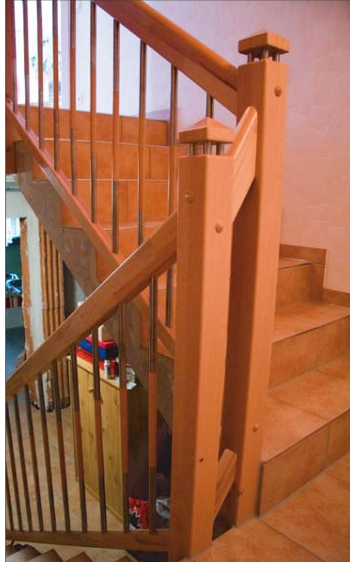
18 Holzgeländer an einer Betontreppe.
