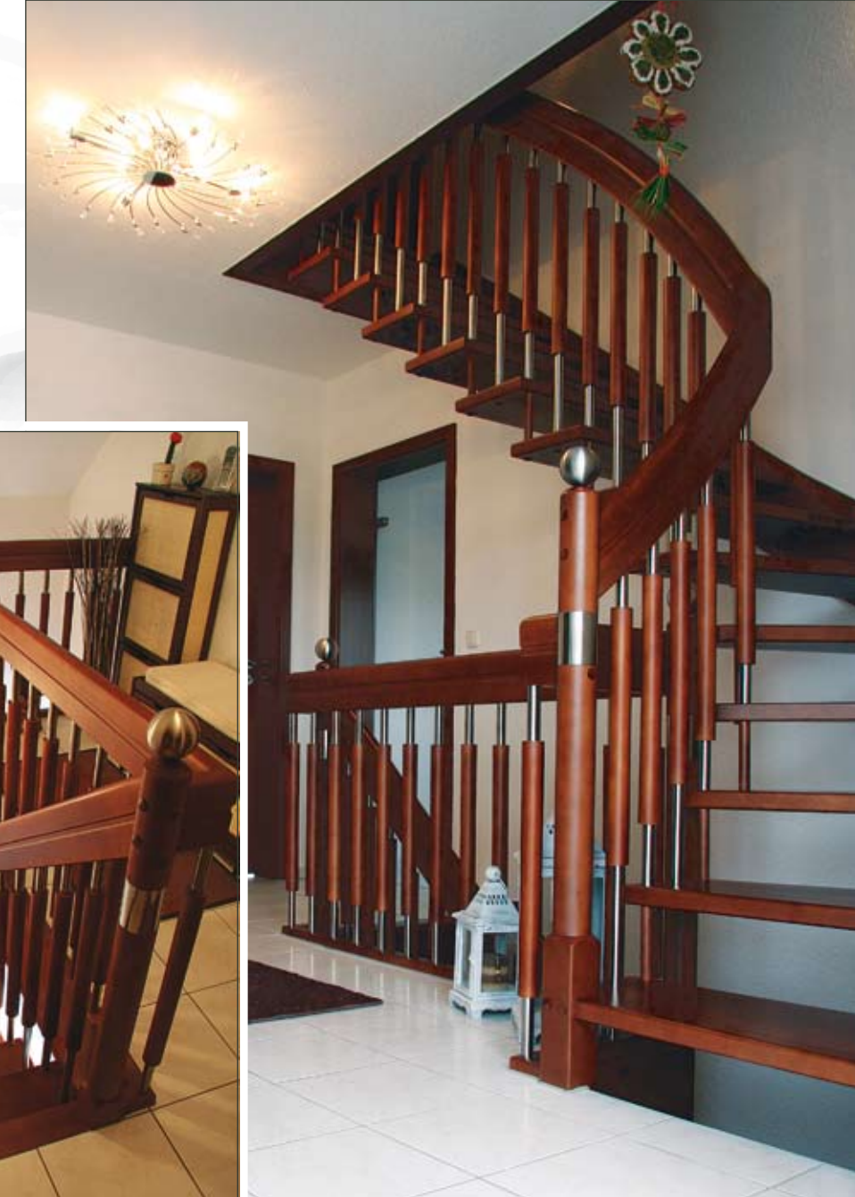
13 Massivholzbolzentreppe ¼-gewandelt in Buche gebeizt ohne Eckpfosten mit Edelstahlelementen in den Geländerstäben und Pfosten.
