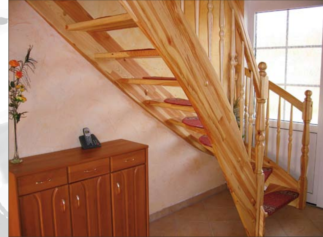
5 Massivholzwangentreppe 1/4-gewandelt in Kiefer mit gedrehten Geländerstäben und Pfosten.
