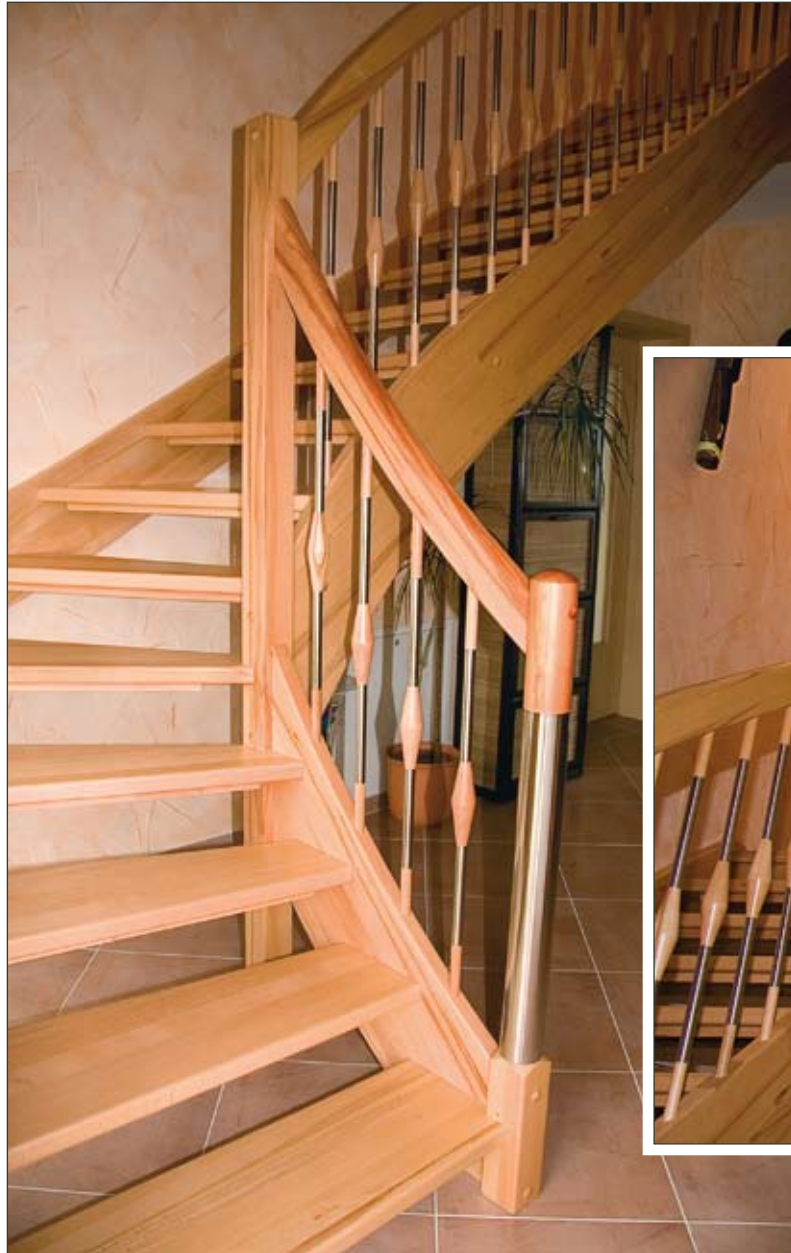
7 Massivholzwangentreppe ¼-gewandelt in Buche mit Edelstahlgeländerstäben und Edelstahlpfosten.
