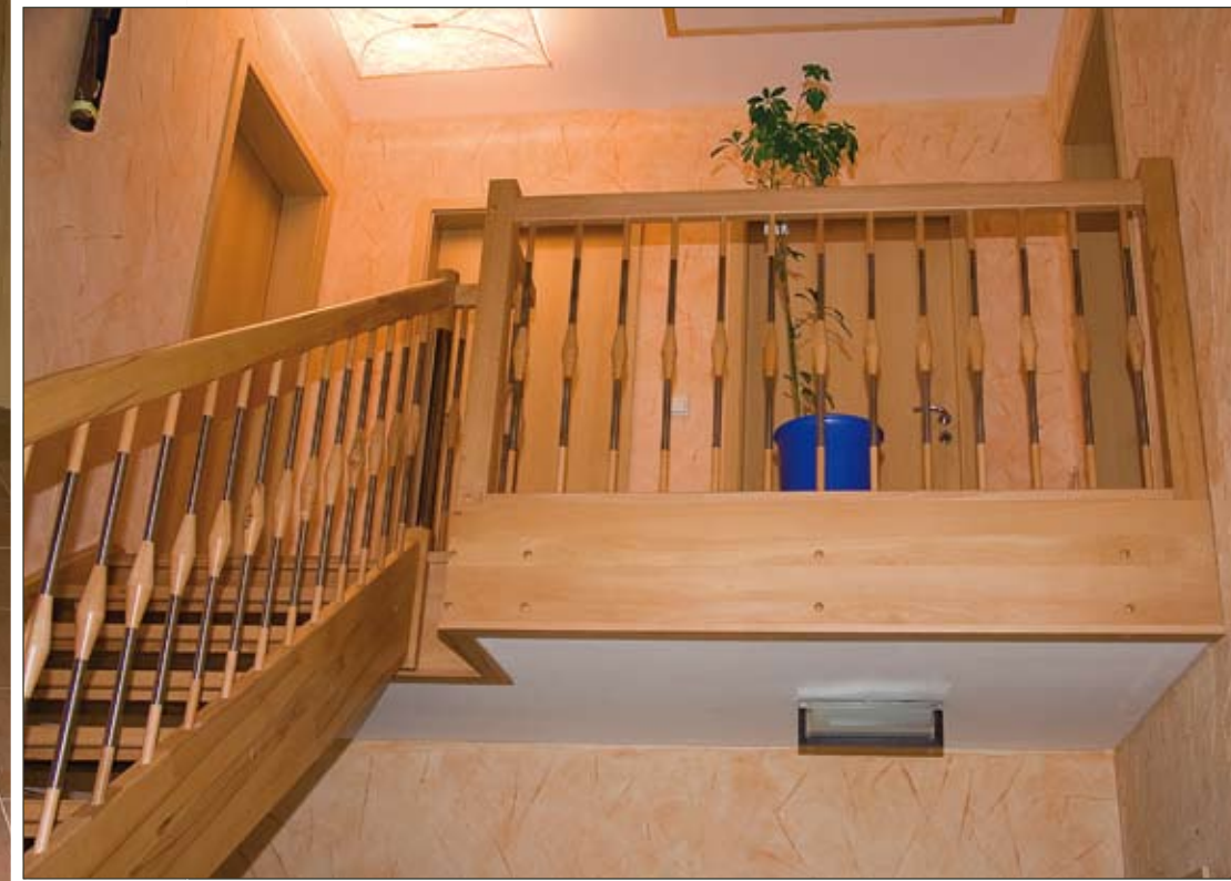
7 Massivholzwangentreppe ¼-gewandelt in Buche mit Edelstahlgeländerstäben und Edelstahlpfosten.
