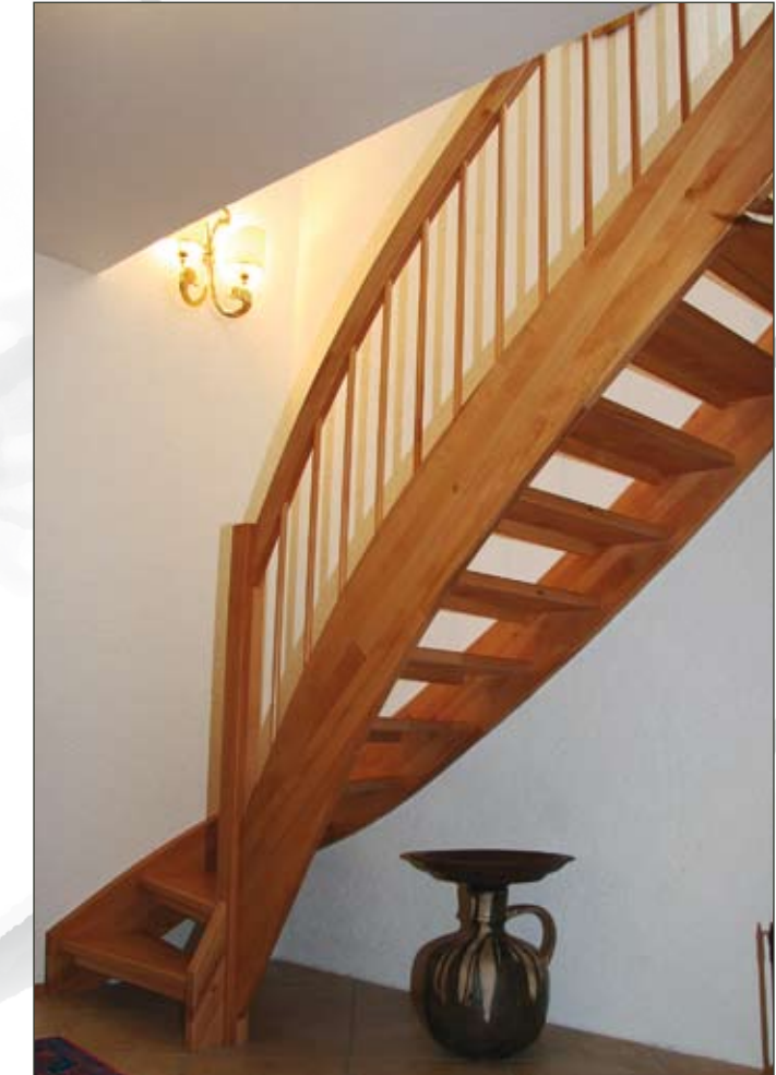
2 Massivholzwangentreppe 1/4-gewandelt in Buche. Standardausführung.
