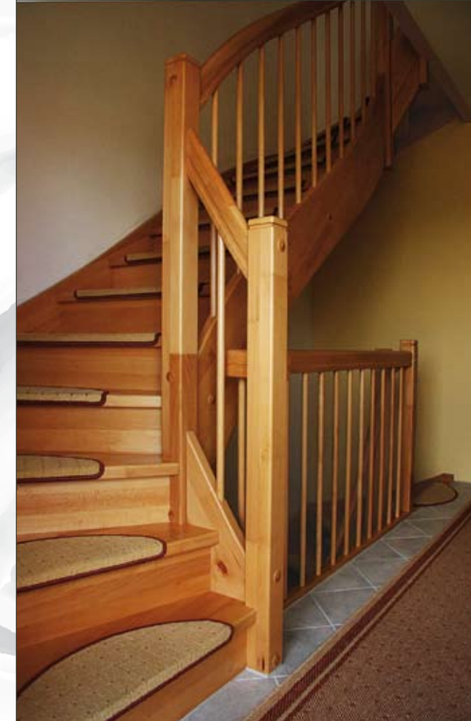
8 Massivholzwangentreppe ¼-gewandelt in Buche. Standardausführung mit Setzstufen.
