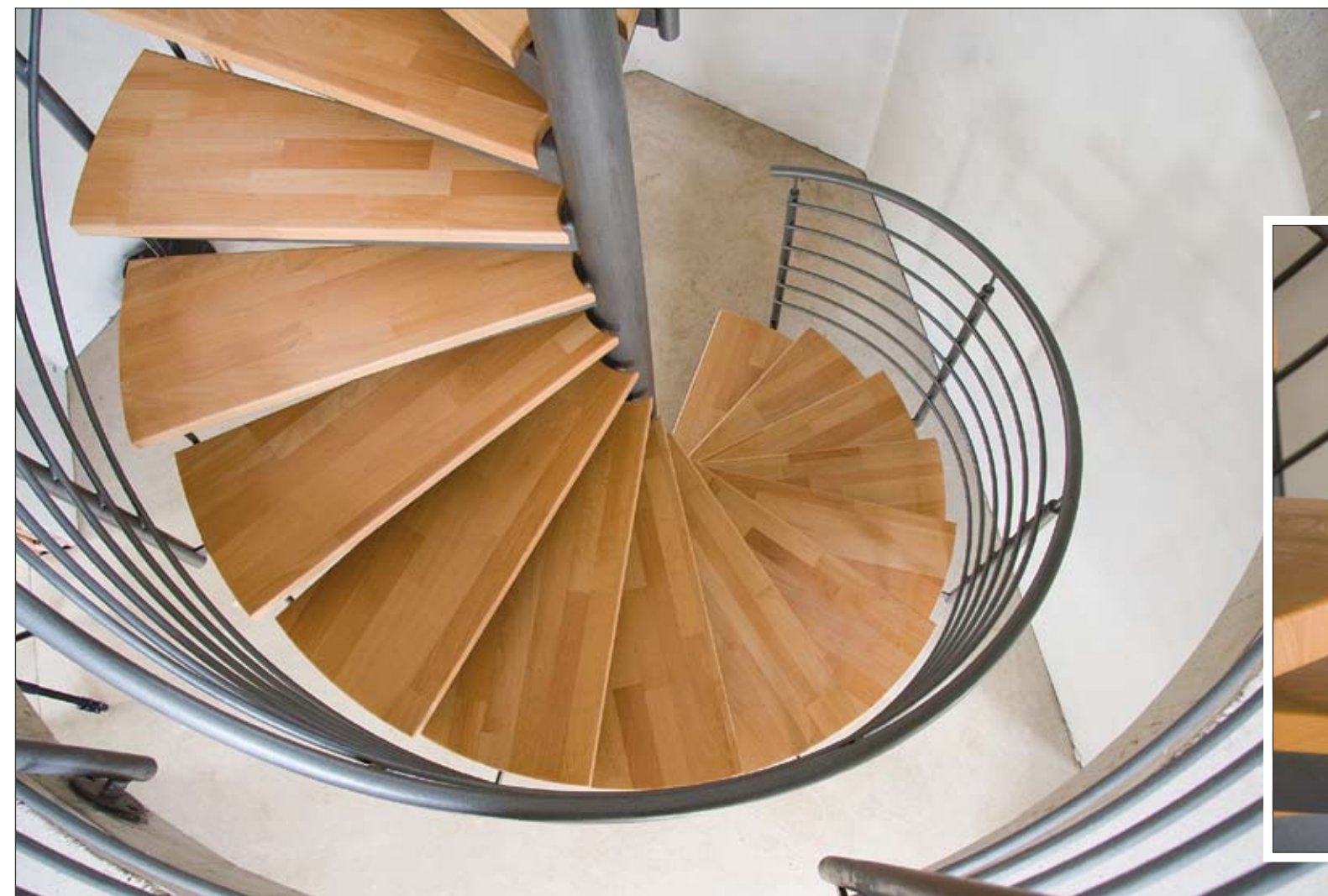
28 Spindeltreppe mit Stahlunterkonstruktion. Buchenstufen.
