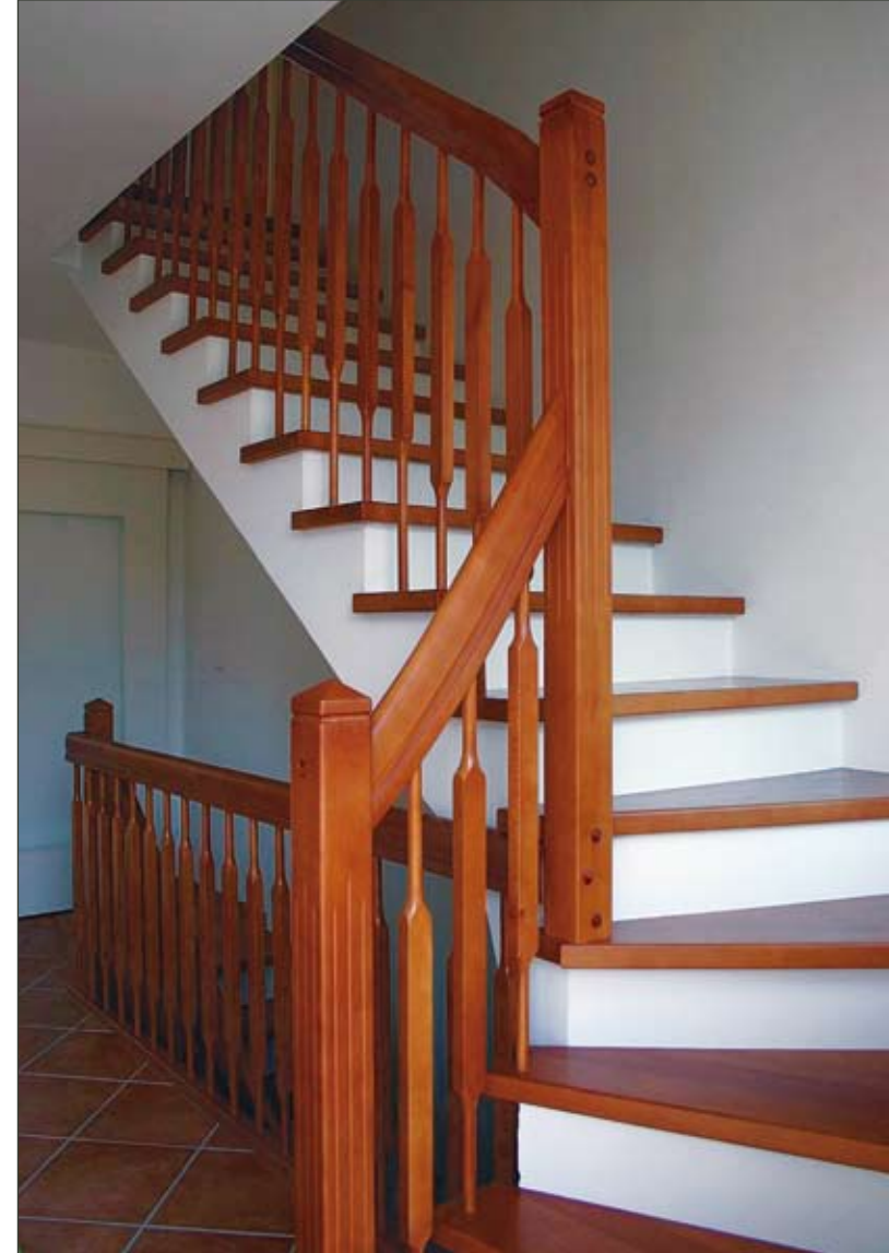
19 Holzgeländer und Holzstufen gebeizt an einer Betontreppe.
